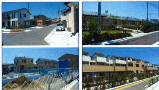
防災による移転住宅の建設
