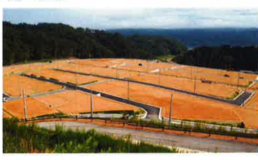
・防災集団移転促進事業による高台造成もほぼ完了、秋から宅地引き渡し予定
