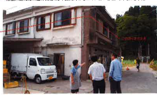
・津波に耐えたRC造の商店(毎年訪問)、かさ上げに伴い移転・取り壊しを予定
