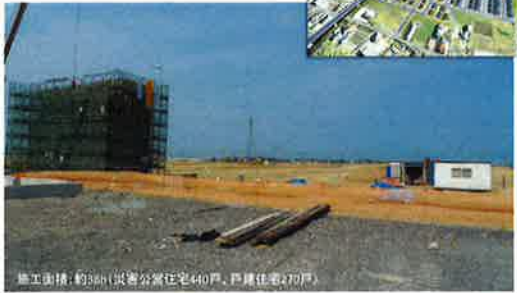
施工面積 約36ha (災害公営住宅440戸、戸建住宅270戸)
