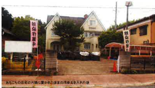
あちこちの瓦葺の片隅に置かれた漆塗の瓦を土を入れた袋
