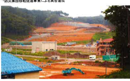
・防災集団移転促進事業による高台造成
