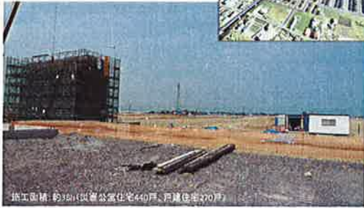
施工面積: 約38ha(災害公営住宅440戸、戸建住宅270戸)
