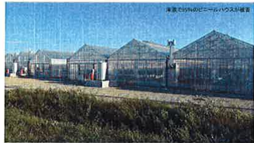
津波で壊れたイチゴのビニールハウスが被害
