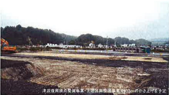
津波復興高台整備事業・土地区画整理事業で約3mのかさ上げを予定
